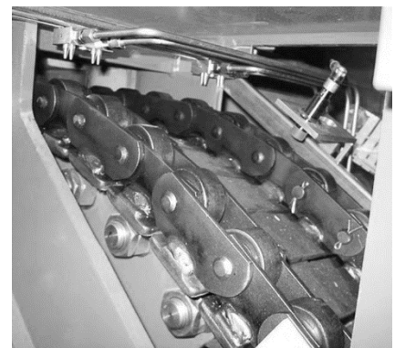
Rolltreppen-Ketten-Schmierung
